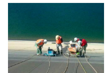
ダ ム (アスファルト遮水型)
